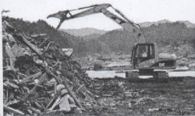
膨大な災害廃棄物の処理に向けて廃棄 物処理業者が動き出している
