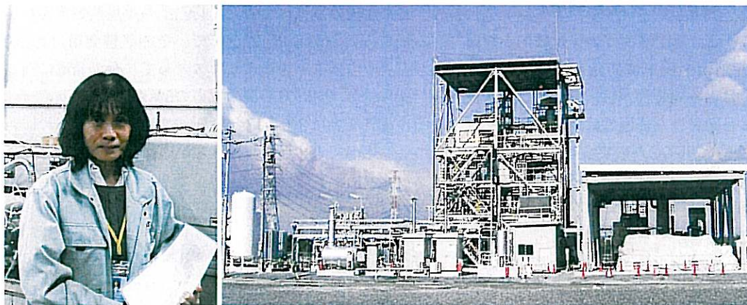
写真左：産総研の 小木知子主任研究員。写真右：三菱 重工業、中部電力、 産総研の3者は01 年から04年にか けてNEDOバイオ マスプロジェクト で木材ガス化-メ タノール製造プラ ントを共同で建設 し、世界初の安 定・連続運転に成 功した(写真提 供：三菱重工業)
