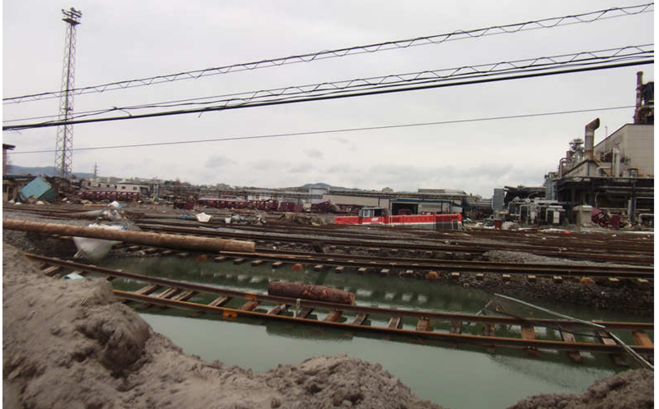
2-8 日本製紙石巻工場 流された構内鉄道
