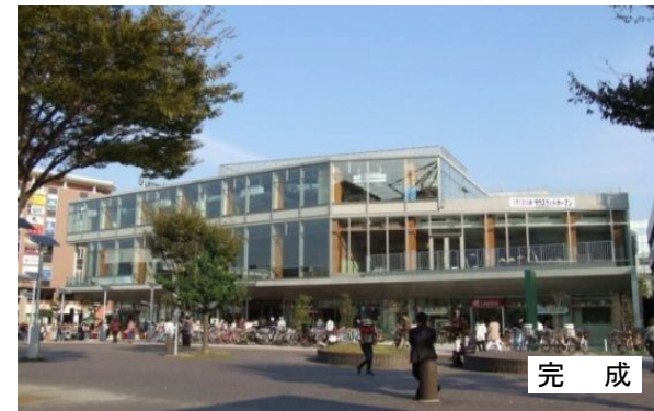
2階~4階部分が木造とRC造混構造
