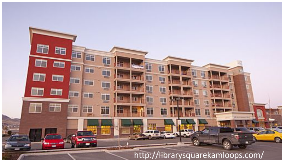
木造6階建てビルディング (カナダ・カムループス)
