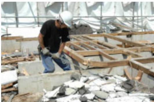
アンカーボルトナット取外し
