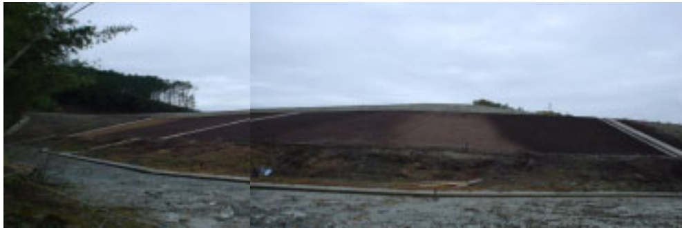
吹付後の全景(11月25日)
