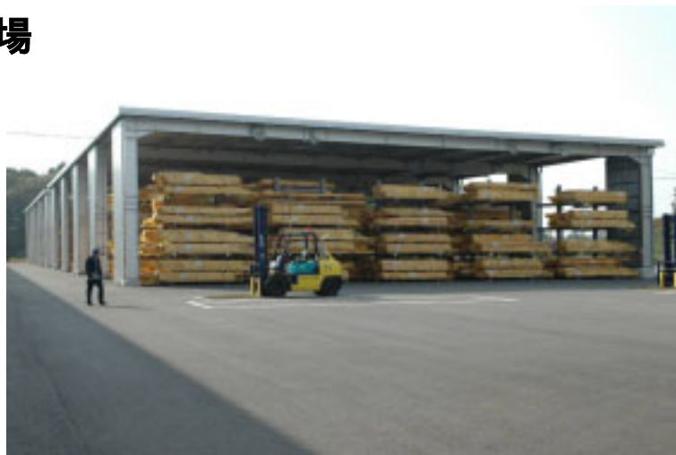
工場内 加工済み(出荷前)製品置き場
