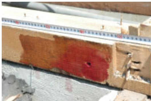
防腐指示薬を塗布した状況
