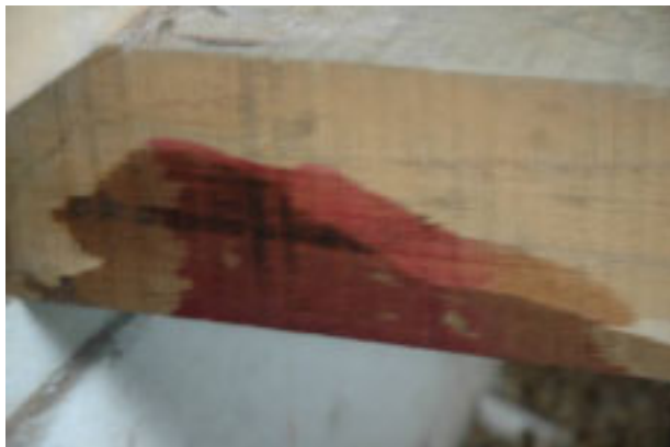
●床を一部解体後試薬塗布
