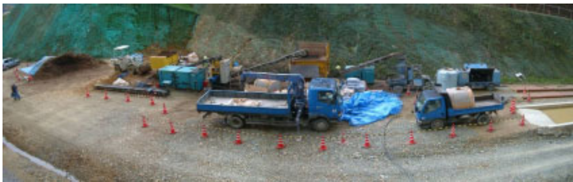
吹付プラント設置状況(4m x 32m)
