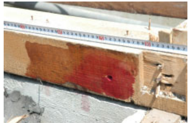
●土台撤去後試薬を塗布
