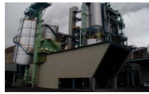
宇部興産㈱火力発電所内のチップ受入施設(山口県)
