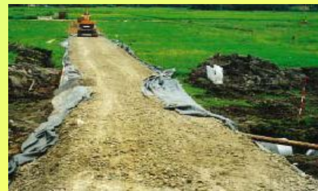
軽量気泡コンクリート廃材による軽量盛土
