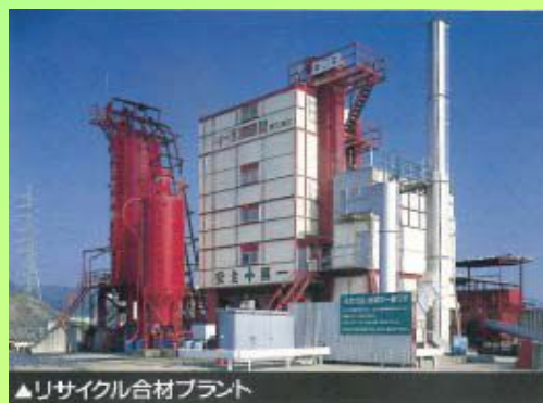
アスファルト・コンクリート塊、コンクリート塊のリサイクル
