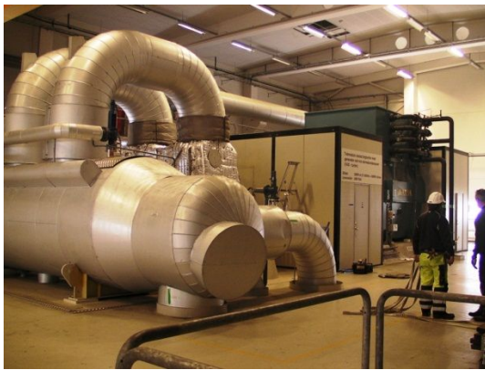
発電タービン（左が出力 38,000kWh、右が出力 28,400kWh）
