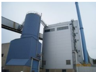
バイオマス発電所
