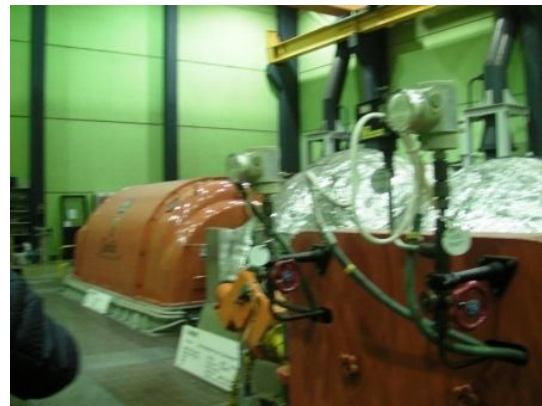
発電タービン（左が出力 38,000kWh、右が出力 28,400kWh）
