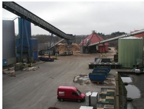
チップヤード&投入コンベアの一部
