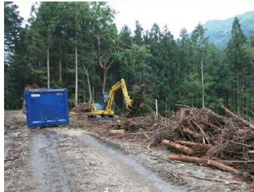
全木集材で発生し道路わきに集積され枝葉等を道路から回収
